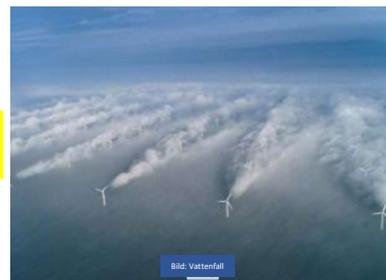
Vergleichbar mit den Wirbelschleppen von Flugzeugen werden die Druckpulse der WKA in Wolkenbildern sichtbar. Die Druckänderungen sind noch in mehr als 20 km nachweisbar.
