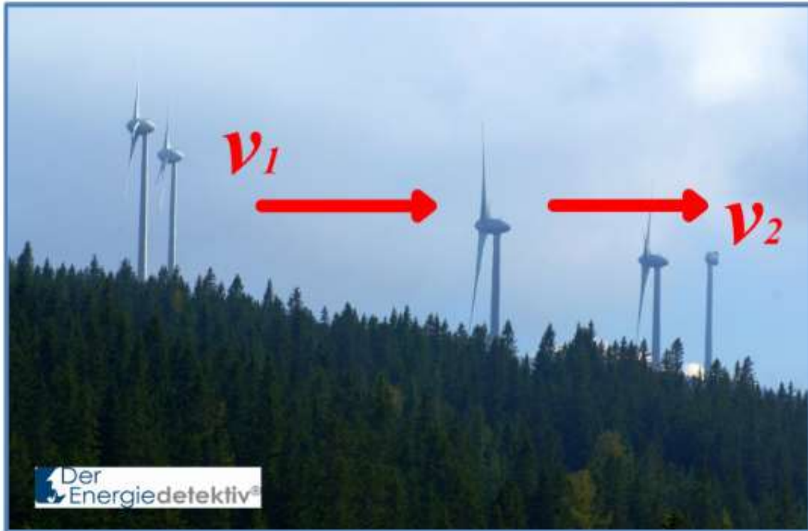
Bild 9-6: Bei der Windenergie wird kinetische Energie der Luftströmung in elektrische Energie umgewandelt. Damit ist nach einem Windrad die Luftgeschwindigkeit kleiner und die kinetische Energie der Luftströmung geringer
